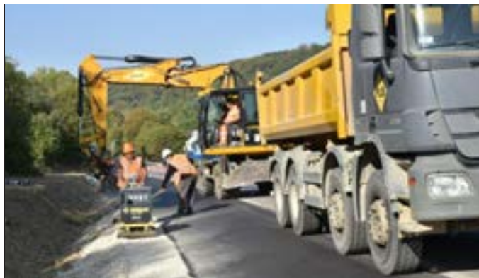
La création d'élargissements provisoires sur les sections de zones de travaux est en cours. Photo RL
