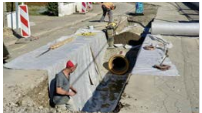
Les travaux, rue Principale, doivent durer deux mois. Photo RL
