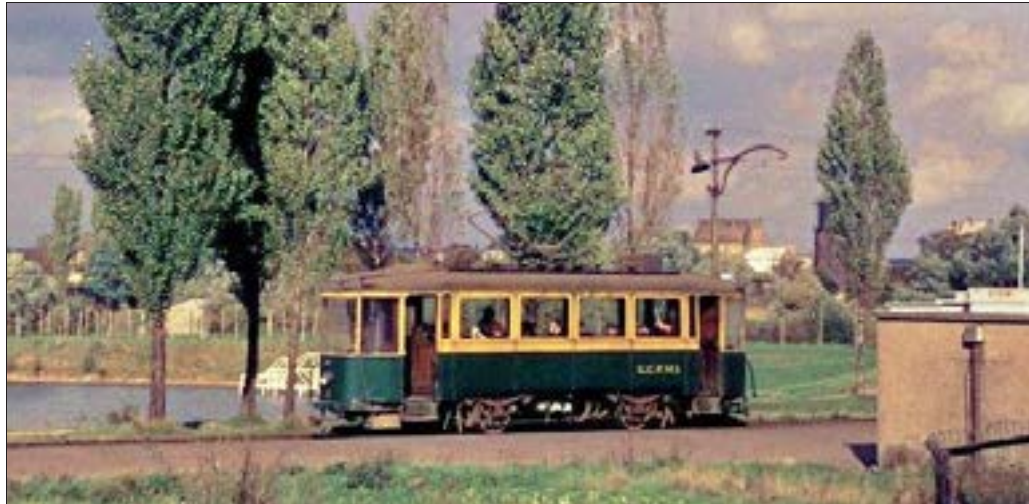
Quatre motrices de 36 CV et une de 58 CV équipaient le parc des tramways hagondangeois jusqu'en 1964. Photo Droits réservés
