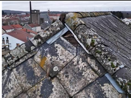
Photo n° PhA007 Localisation : Couvertures Ouvrage : 4. Eléments extérieurs - Toitures Partie d'ouvrage : Accessoires de couvertures (fibres-ciment) Description : Faîtières en fibre-ciment type "Eternit" ou similaire
