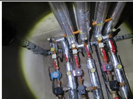
Photo n° PhA008 Localisation : S-Sol - Chaufferie Ouvrage : 1. Flocages, Calorifugeages, Faux plafonds Partie d'ouvrage : Calorifugeages Description : Calorifugeages (coquilles laine de roche-aluminium)
