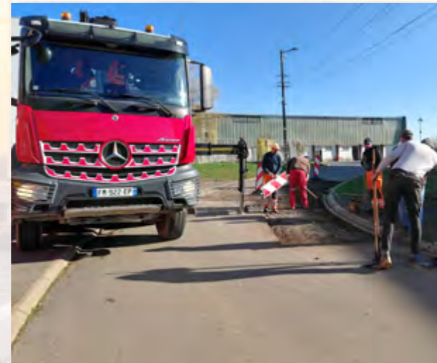
Divers travaux de rebouchage ont été effectués
