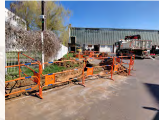
Remplacement de la conduite de gaz qui alimente le gymnase suite à une fuite
