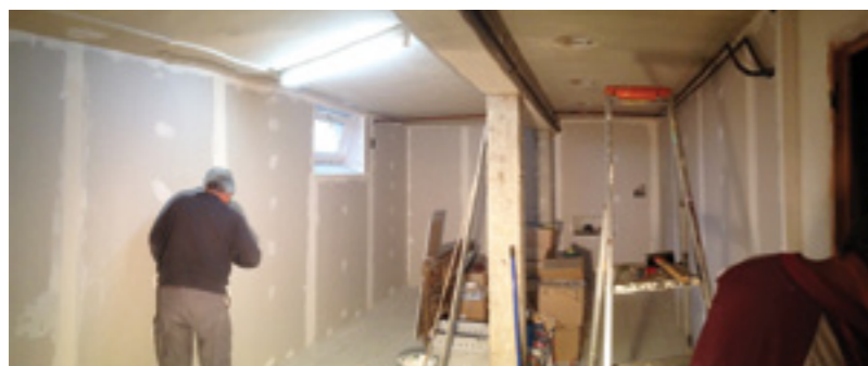
Réfection du sous-sol de la Mairie
