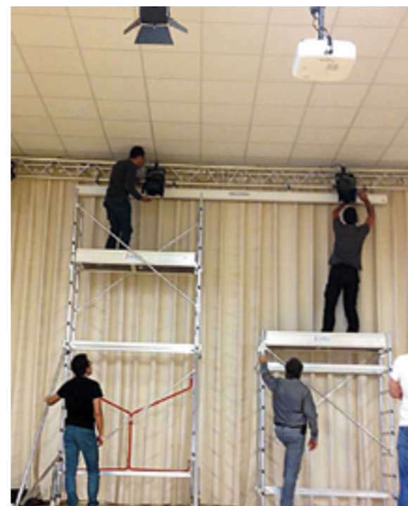
Installation d'un vidéo-projecteur avec écran à la salle polyvalente.
