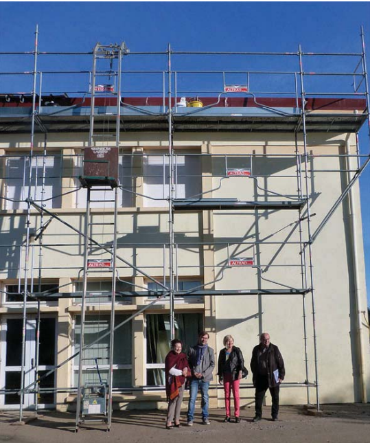
Toiture de l'école primaire
