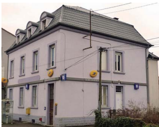
Réhabilitation du 1er étage de la Poste occupé par la CCPHVA
