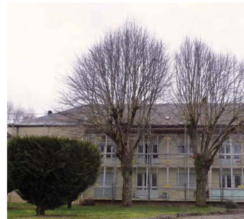
Remplacement des fenêtres et toiture des logement communaux.
