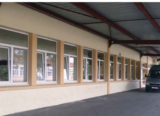
Menuiseries du Groupe scolaire
