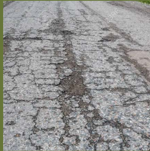
ROUTES ET TROTOIRES endommagés
