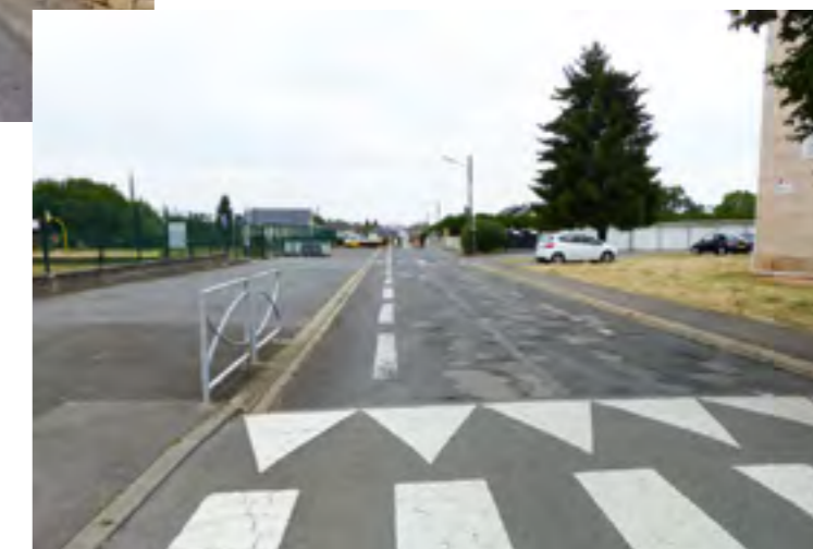
Réfection rue du cimetière du passage surélevé jusqu'au rétrécissement des maisons
