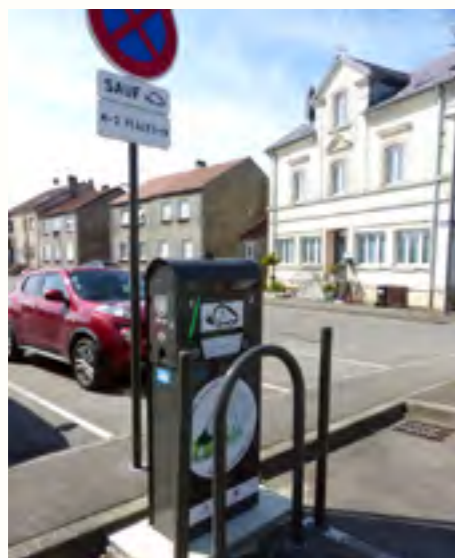
Le raccordement de la borne de recharge pour véhicule électrique a été effectué
