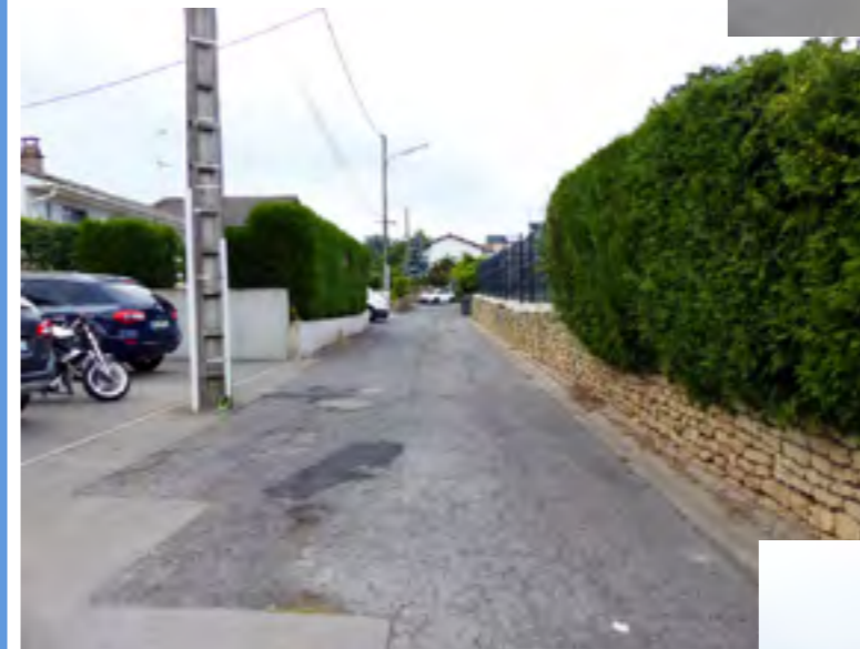
Réfection de la rue de Verdun
