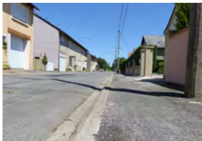
Réfection des trottoirs rue des Prés
