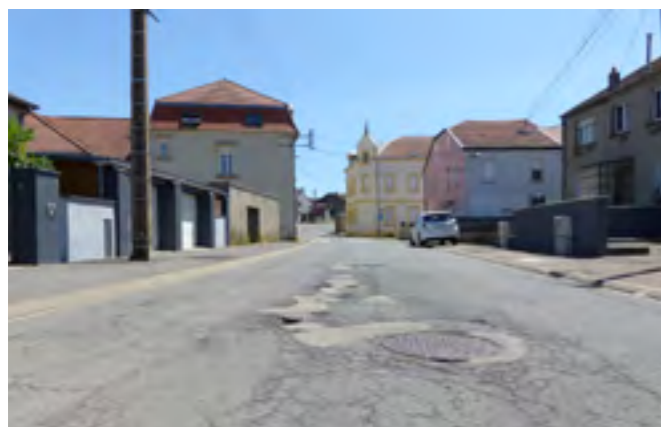
Réfection rue Maréchal Joffre (Derrière l'église)
