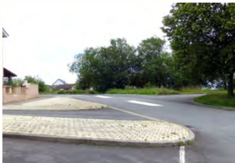
Passage surélevé rue du Puits
